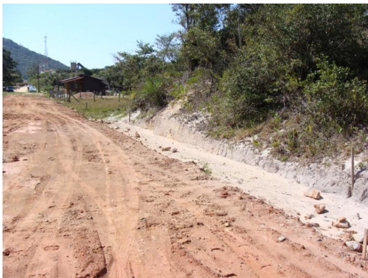
Figura 13. Corte nas dunas para a abertura da via em 16/09/10. Fonte: autor.
