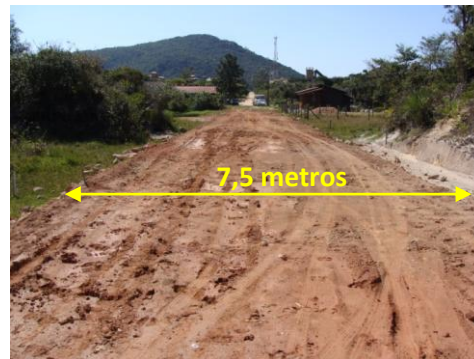
Figura 8. Vista da área aterrada no sentido leste-oeste em 16/09/10. Fonte: autor
