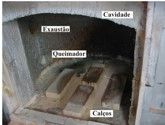
Figura 3.3 - Fotografia mostrando a cavidade do forno, as aberturas para o queimador e para a exaustão, bem como os calços onde repousa o cadinho.
