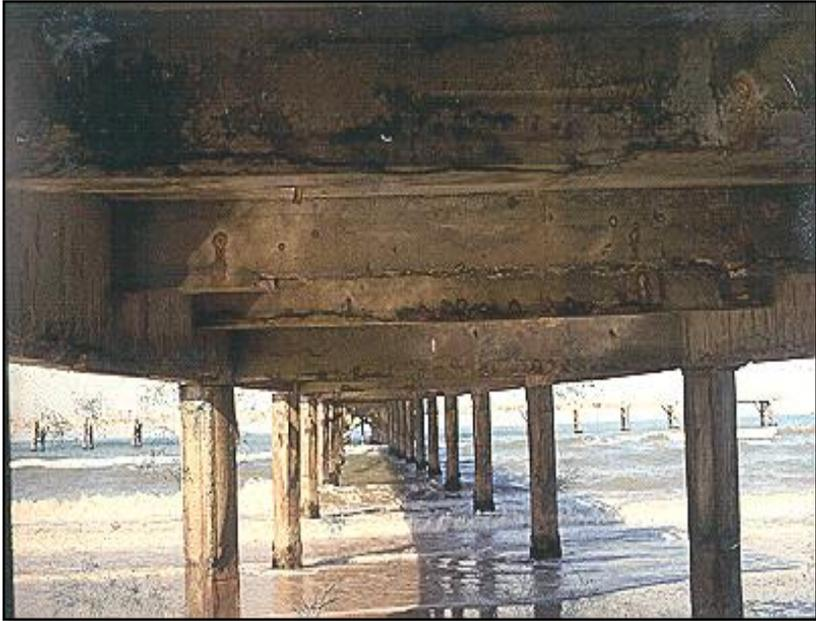
Figura 2.3 – Ataque característico devido à corrosão de armaduras
