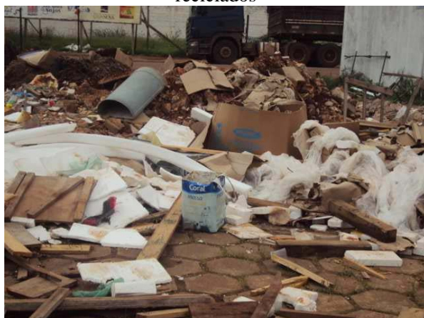
Figura 5 - Acondicionamento indevido de resíduos que poderiam ser reciclados
