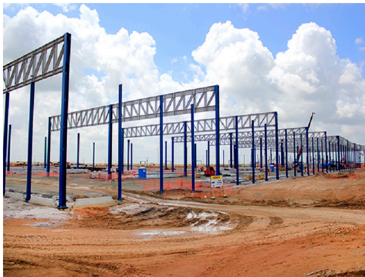
Figura 11 - Visão geral do galpão de prensas em Pernambuco
