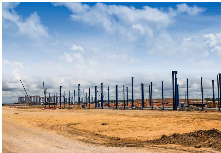
Figura 14 - Visão geral da construção do galpão da Montagem Final em Pernambuco
