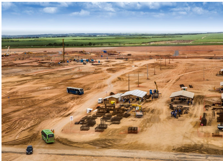
Figura 10 - Visão geral do local onde está sendo instalado o empreendimento
