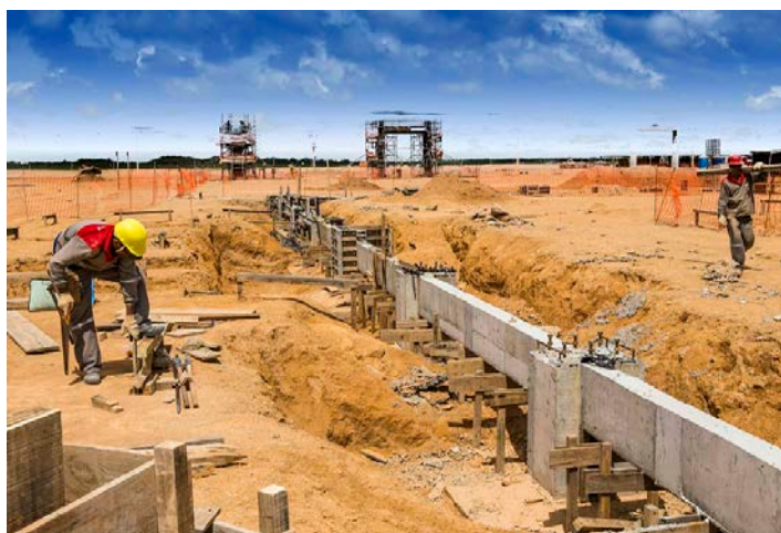
Figura 12 - Visão geral do galpão de funilaria em Pernambuco
