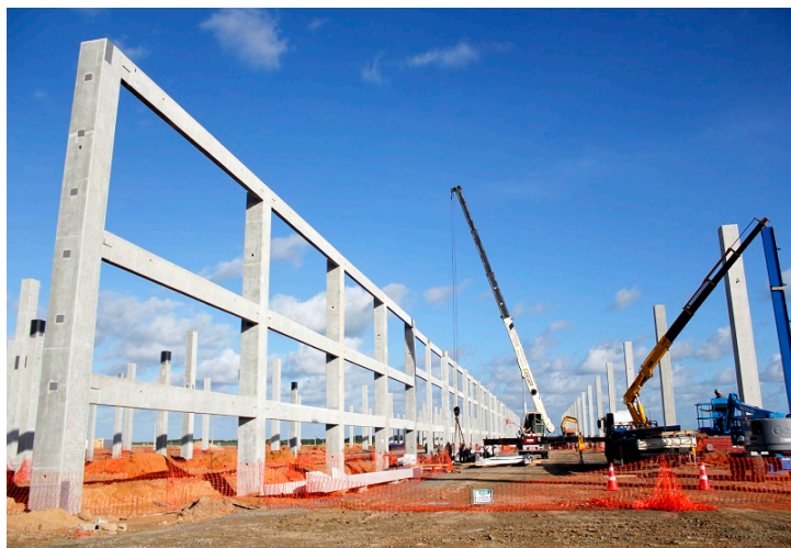
Figura 13 - Visão geral da construção do galpão de pintura em Pernambuco
