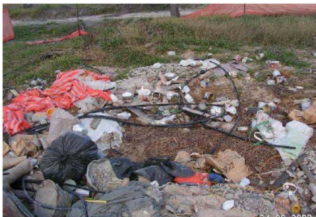
Figura 17 - Exemplo de impacto no solo em obra de engenharia em decorrência de gerenciamento inadequado de Resíduos Sólidos
