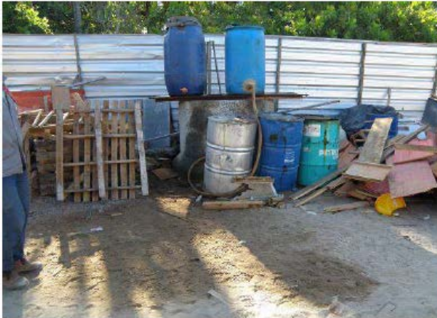
Figura 18 - Exemplo de poluição do solo devido manejo inadequado de óleo em obra de engenharia
