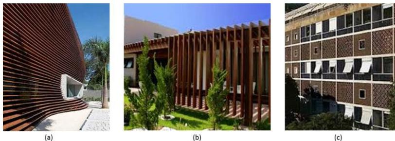
**Figura 12:** Tipos de elementos de proteção solar: (a) brises horizontais; (b) brises verticais; (c) cobogó.
