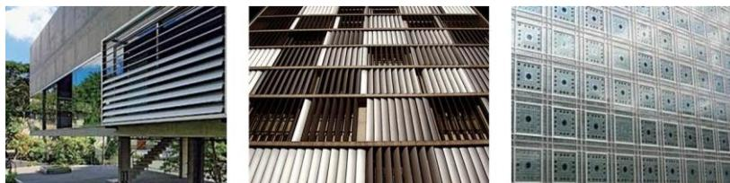
**Figura 13:** Exemplos de protetores solar dinâmicos, manuais ou mecânicos.
