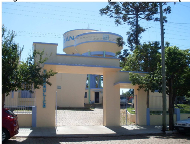
Figura 43 – Local de coleta de água tratada em São Sepé.
