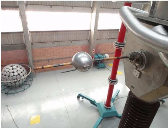
Figura 34 – Dispositivo montado em terminação do aparato experimental.
