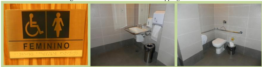
Figura 21 - Sanitário acessível em shopping center
