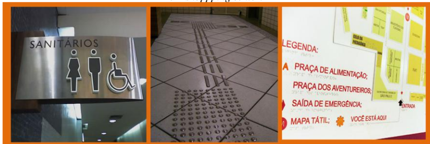
Figura 23- Sinalização visual de sanitário, sinalização alerta e direcional de piso, e mapa tátil para um shopping center .
