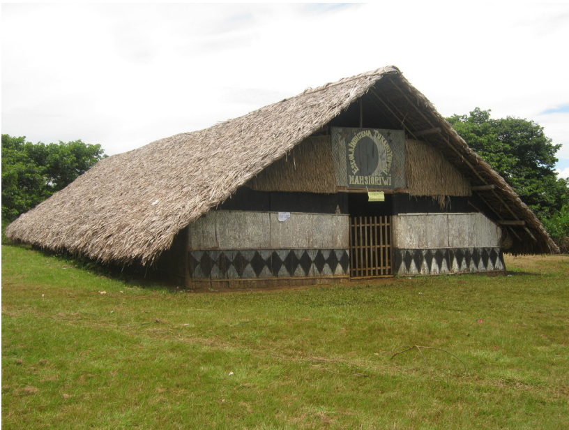
Foto 1: Maloca em São José do Meio
