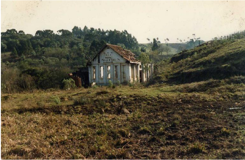
Fotografia 04: Ruínas da Empresa Força e Luz
