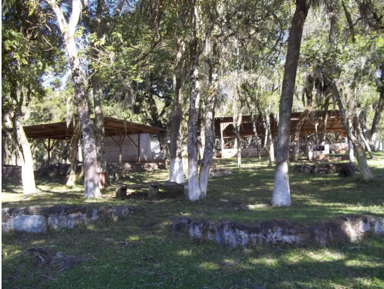
Fotografia 10: Edificações existentes na propriedade.
