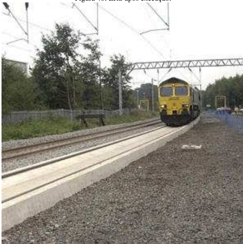
Figura 40: ERS após execução.
