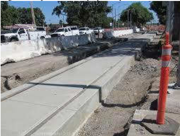
Figura 38: laje de concreto preparada para receber trilhos.
