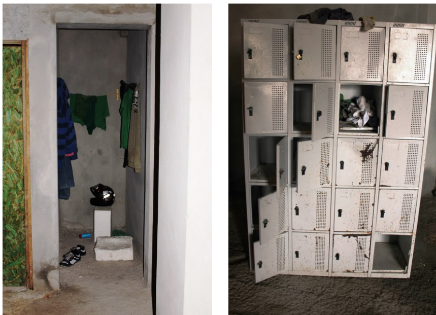
Figura 39 - Vestiário improvisado Fonte: Arquivo pessoal
