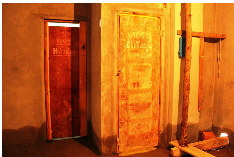
Figura 38 - Depósitos de materiais hidráulicos e elétricos Fonte: Arquivo pessoal
