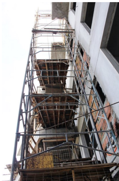
Figura 28 - Torre do elevador Fonte: Arquivo pessoal
