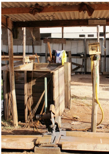
Figura 24 - Corte de armaduras Fonte: Arquivo pessoal
