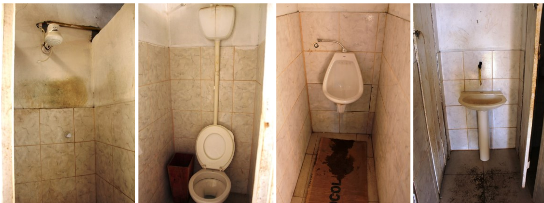
Figura 17 - Instalações Sanitárias Fonte: Arquivo pessoal
