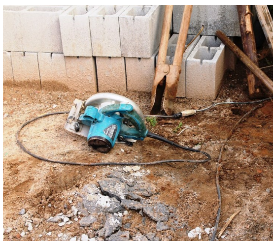
Figura 32 - Instalações elétricas Fonte: Arquivo pessoal
