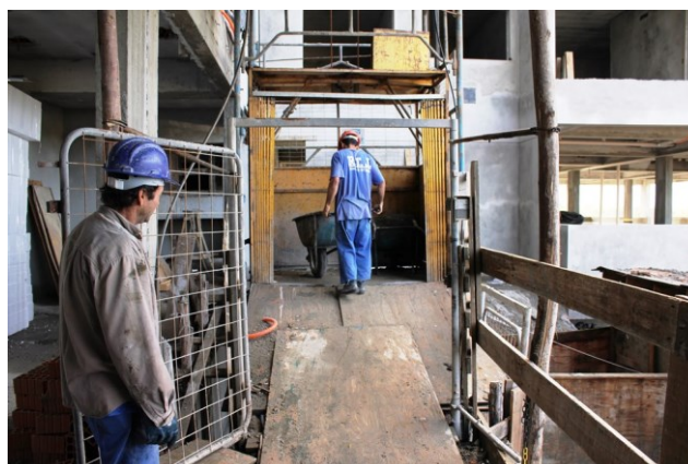
Figura 29 - Elevador de transporte de materiais Fonte: Arquivo pessoal
