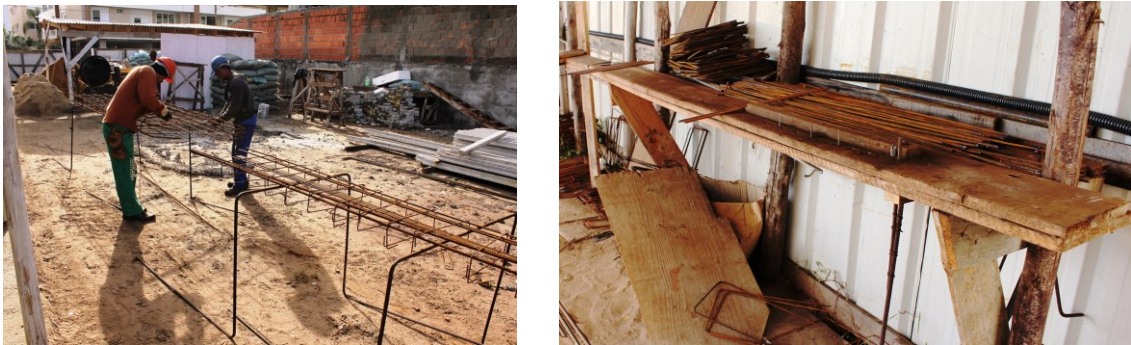
Figura 23 - Dobra de armaduras Fonte: Arquivo pessoal
