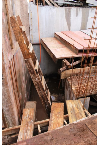
Figura 26 - Armações sem proteção Fonte: Arquivo pessoal
