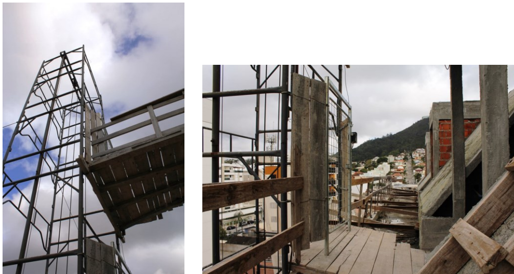
Figura 44 - Elevador de carga Fonte: Arquivo pessoal
