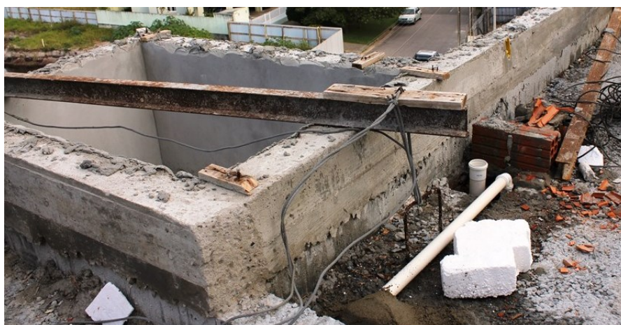
Figura 31 - Fixação do andaime Fonte: Arquivo pessoal
