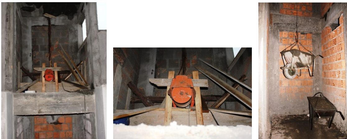
Figura 7 – Guincho para transporte vertical de materiais Fonte: Arquivo pessoal
