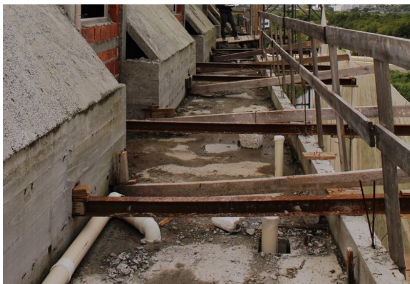
Figura 46 - Fixação dos andaimes Fonte: Arquivo pessoal
