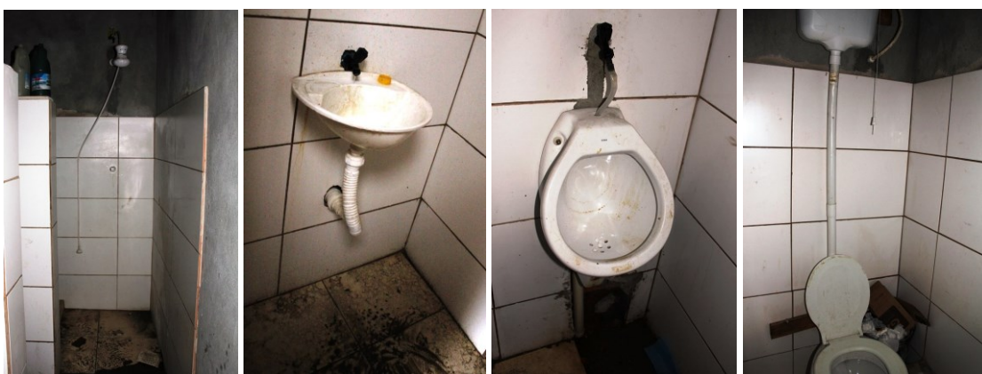
Figura 2 - Instalações sanitárias Fonte: Arquivo pessoal
