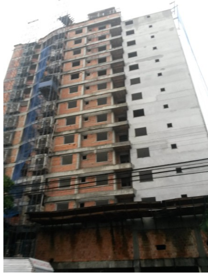
Figura 6 - Canteiro de obras 5
