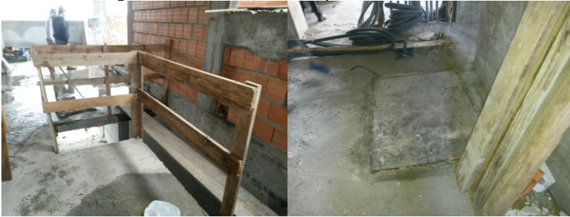
Figuras 32 e 33 - Aberturas no piso com fechamento
