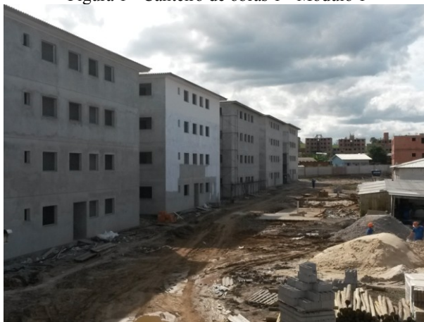
Figura 1 - Canteiro de obras 1 - Módulo 1
