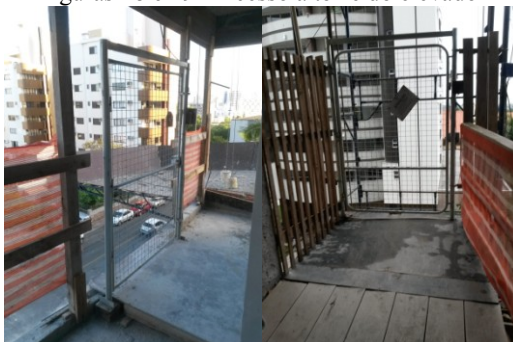
Figuras 48 e 49 - Acesso a torre do elevador
