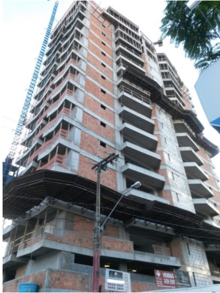
Figura 4 - Canteiro de obras 3
