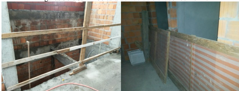
Figuras 38 e 39 - Abertura do vão do elevador conforme
