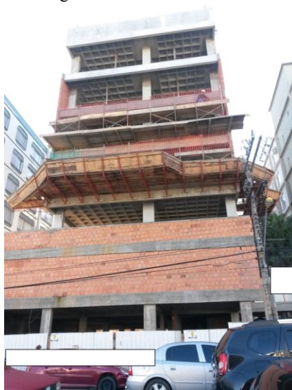
Figura 5 - Canteiro de obras 4
