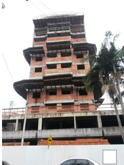
Figura 7 - Canteiro de obras 6
