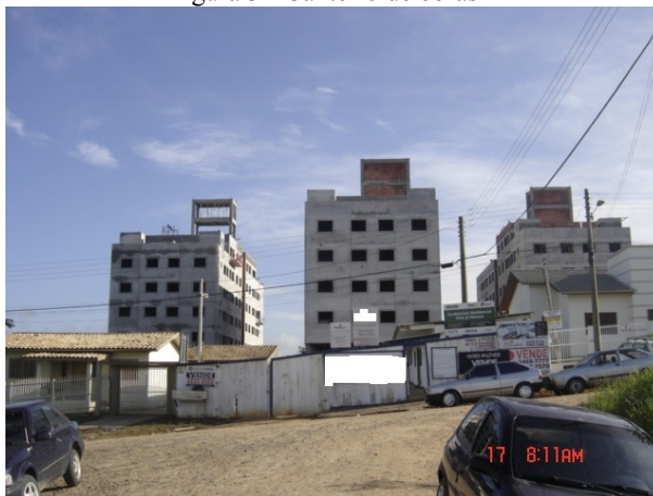
Figura 3 - Canteiro de obras 2
