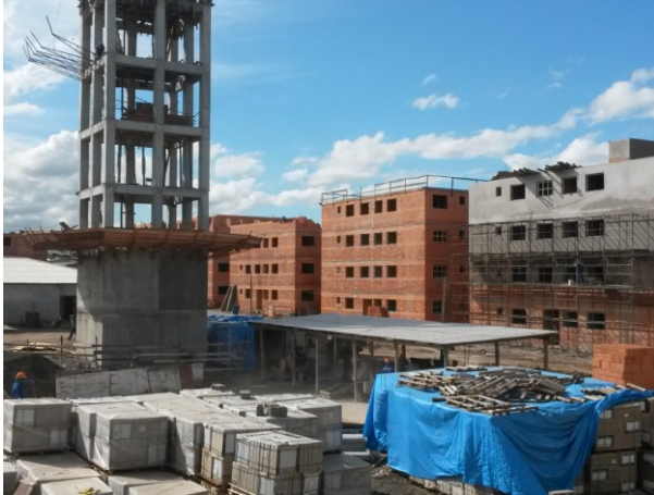
Figura 2 - Canteiro de obras 1 - Módulo 2
