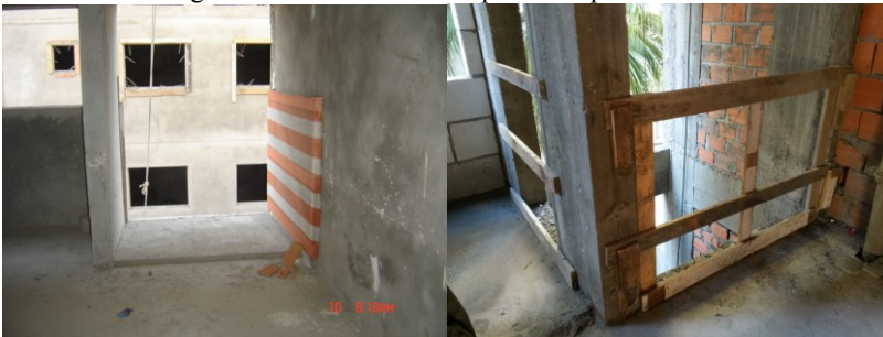
Figuras 34 e 35 - Aberturas para transporte vertical
