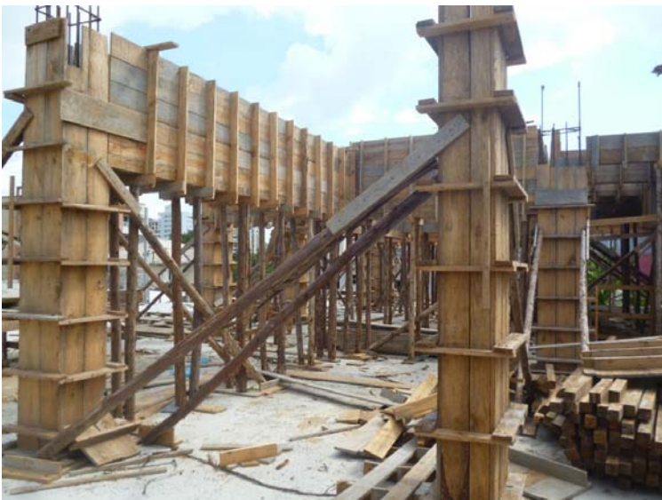
Figura 11 - Formas estrutura pavimento tipo-diferenciado em 27/01/2014.
