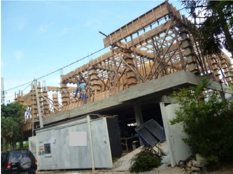
Figura 10 - Estágio da obra em 27/01/14.
