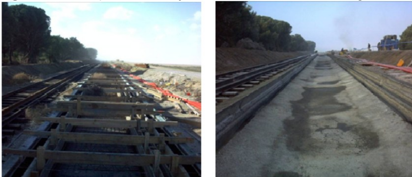
Figura 4.9 - Execução de via em laje de trilho embutido com concretagem in loco
