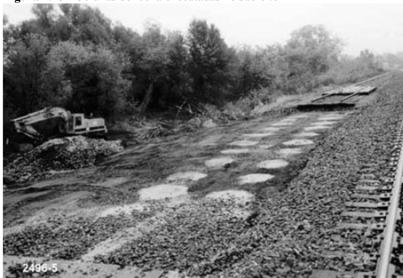
Figura 4.15 - Colunas de rocha executadas no subleito
