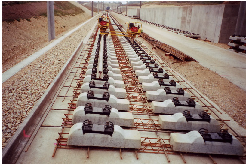
Figura 4.2 - Dormentes do sistema Rheda 2000, antes de serem embutidas em concreto
