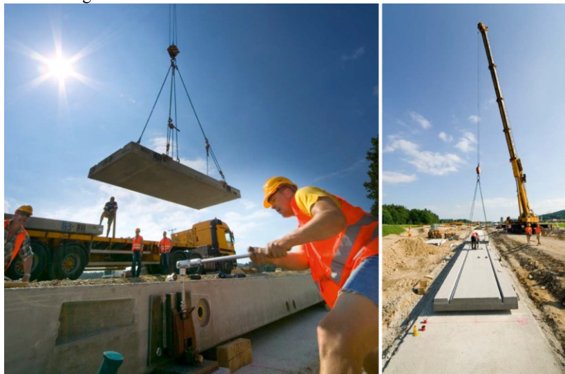
Figura 4.5 - Suspensão da placa pré-fabricada para execução da via em laje no sistema Bögl
