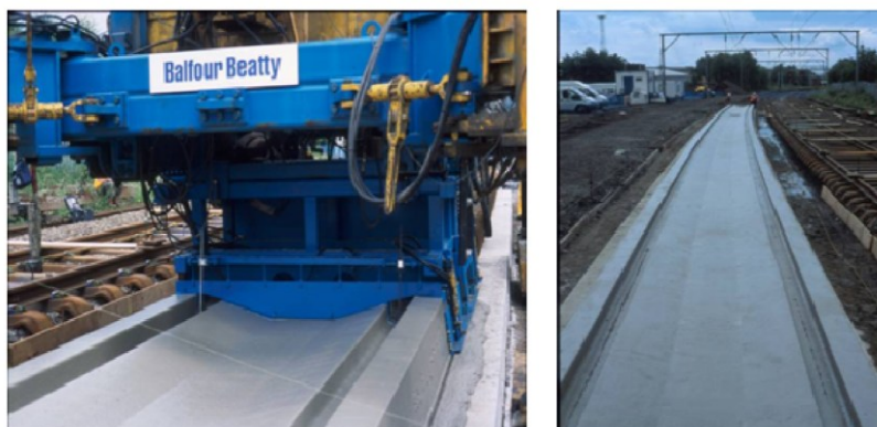
Figura 4.11 - Execução de via em laje de trilho embutido com forma deslizante
