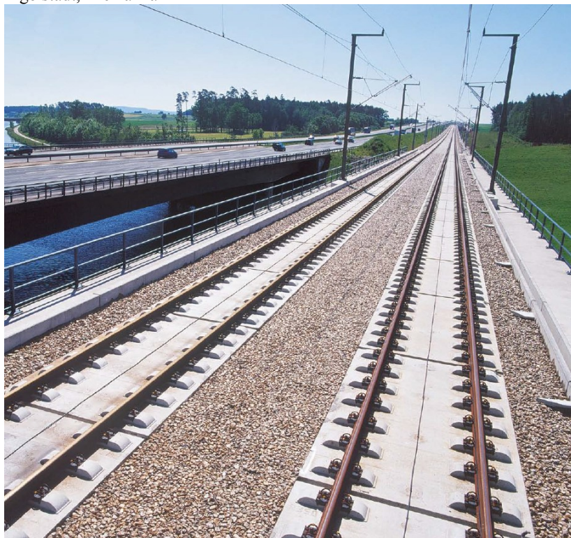
Figura 4.3 - Sistema de laje pré-fabricada Bögl, na linha que liga Nuremberg e Ingolstadt, Alemanha
