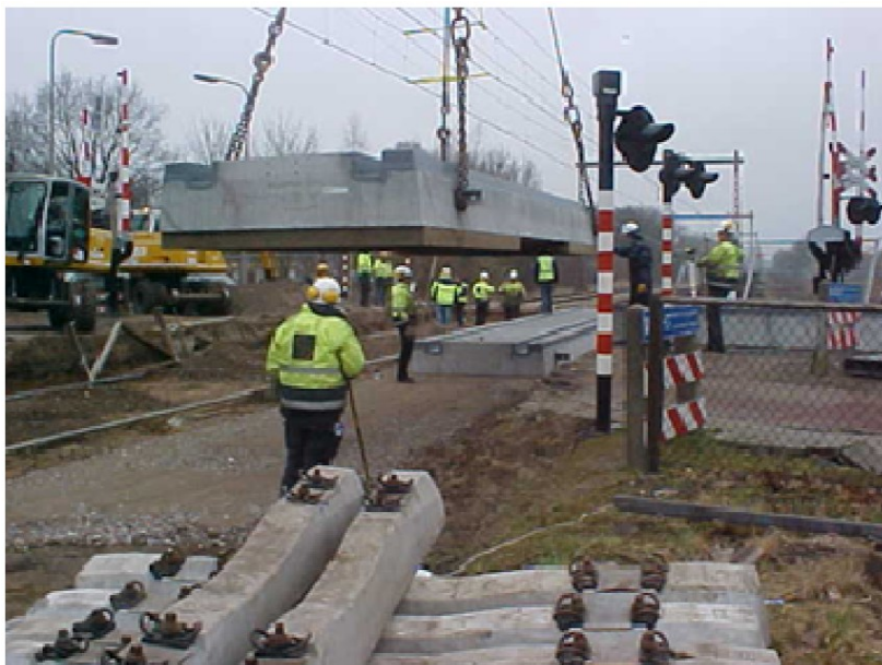
Figura 4.10 - Execução de via em laje de trilho embutido com placas pré-fabricadas
