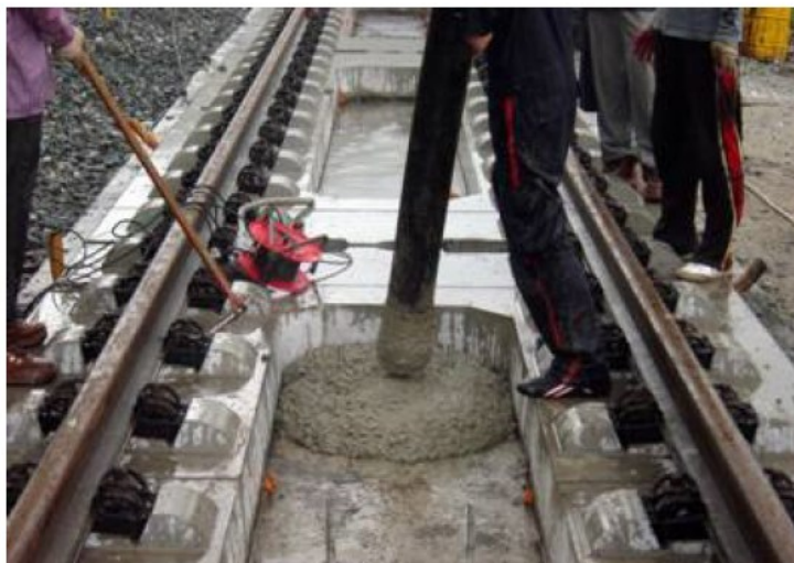
Figura 4.21 - Preenchimento dos vãos das placas pré-fabricadas com concreto
