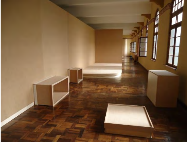
Figura 19: Construção do Módulo Formação
