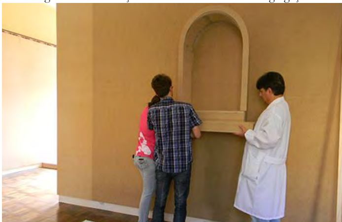
Figura 16: Construção do nicho do Módulo Congregação
