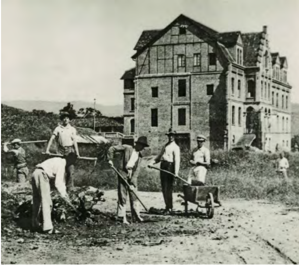
Figura 18: Construção do Seminário
