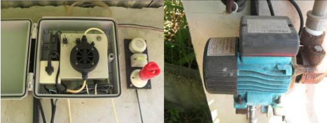
Figura 10: Bomba hidráulica automática para a injeção de Cloro (esquerda) e bomba hidráulica periférica de motor monofásico usada na distribuição de água (direita).
