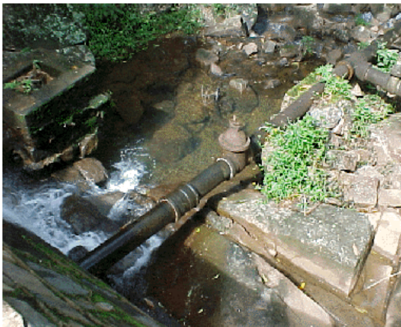
Figura 2: Captação de água Fonte: CASAN (2009).
