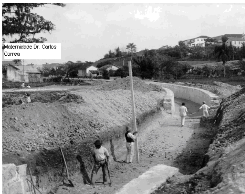
Figura 17: Homens trabalhando na construção do canal do Rio da Bulha Fonte: Acervo IHGSC.
