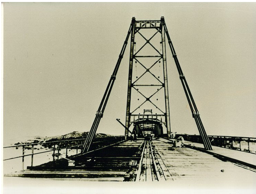
Figura 13: Construção da Ponte Hercílio Luz. Fonte: Acervo IHGSC.
