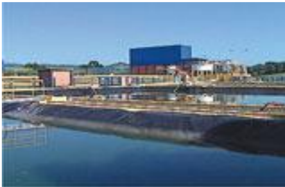
Figura 8: Estação de Tratamento dos efluentes. Fonte: Pioneiro Ecometals (2009).
