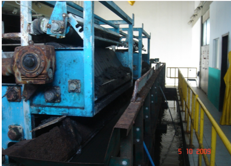
Foto 2 - Máquina usada no processo de desidratação do lodo de esgoto.
