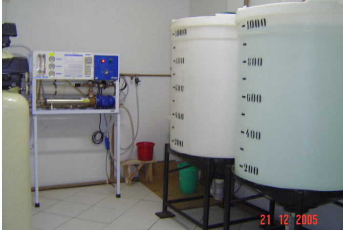
Foto 4: Sala de tratamento de água clínica APAR VIDA.
