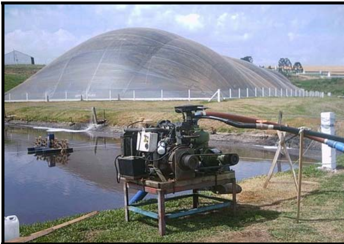
Figura 6: Bomba recalque para retirada do líquido da lagoa de maturação.
