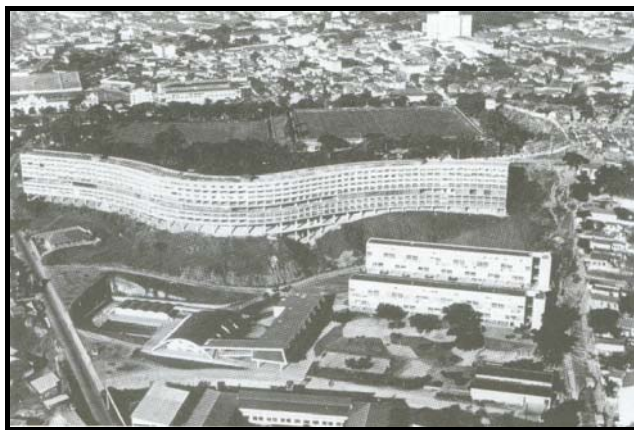
Figura 08: Conjunto Residencial Pedregulho – o mais conhecido do Brasil Fonte: BONDUKI, 1998
