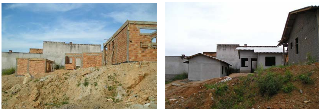
Figura 16: Construção das primeiras unidades habitacionais Fonte: Engº Jorge Augusto Lopes, 2005.
