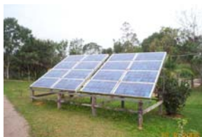
Foto 13 – Painel de energia solar
