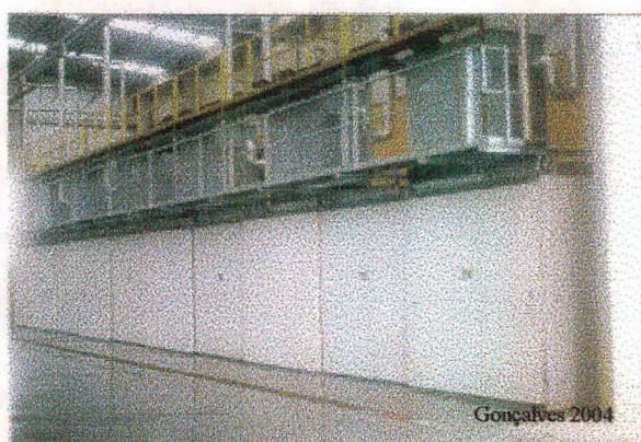
Figura - 7: Vista lateral do equipamento Hidrocooler.
