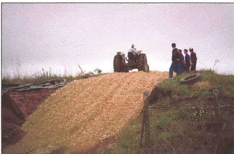
Foto 14 - A compactação do material no silo.
