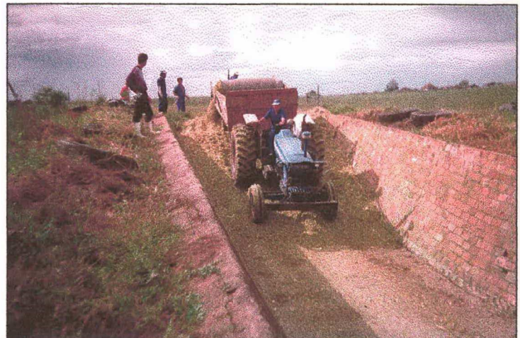
Foto 13 - Descarregamento do material no silo.
