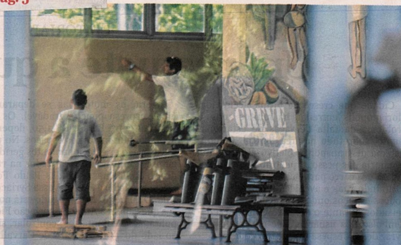
Reforma. Durante o fim de semana equipes trabalharam para restaurar espaço da universidade federal catarinense
