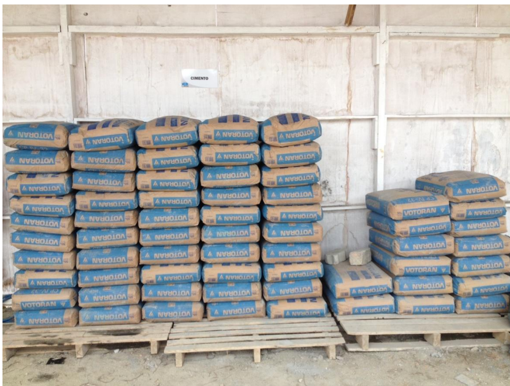
Figura 41 - Identificação dos materiais com placa em acrílico. Fonte: Acervo da autora.
