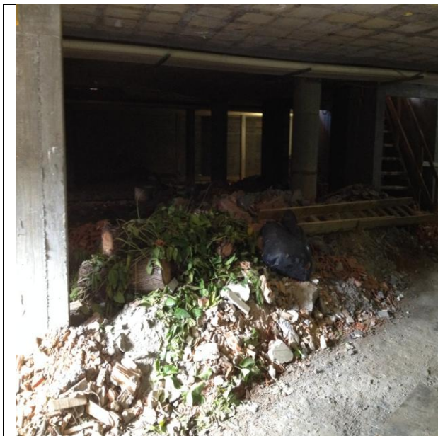
Figura 3 - Resíduos armazenados no subsolo da obra da empresa X. Fonte: Acervo da autora.
