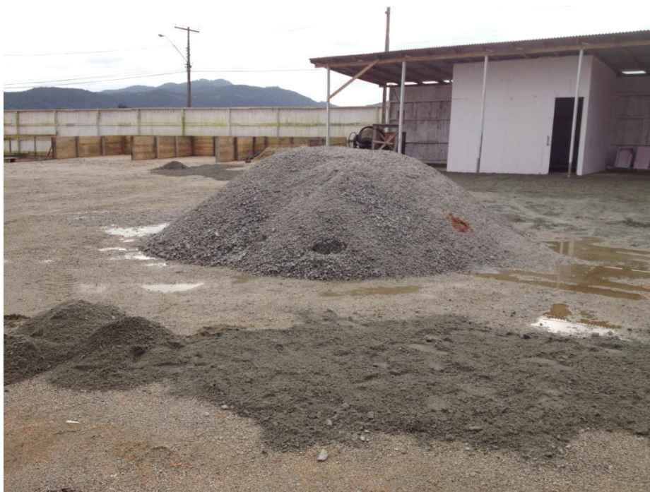
Figura 34 - Materiais soltos e sem identificação no canteiro antes do 5S. Fonte: Acervo da autora.
