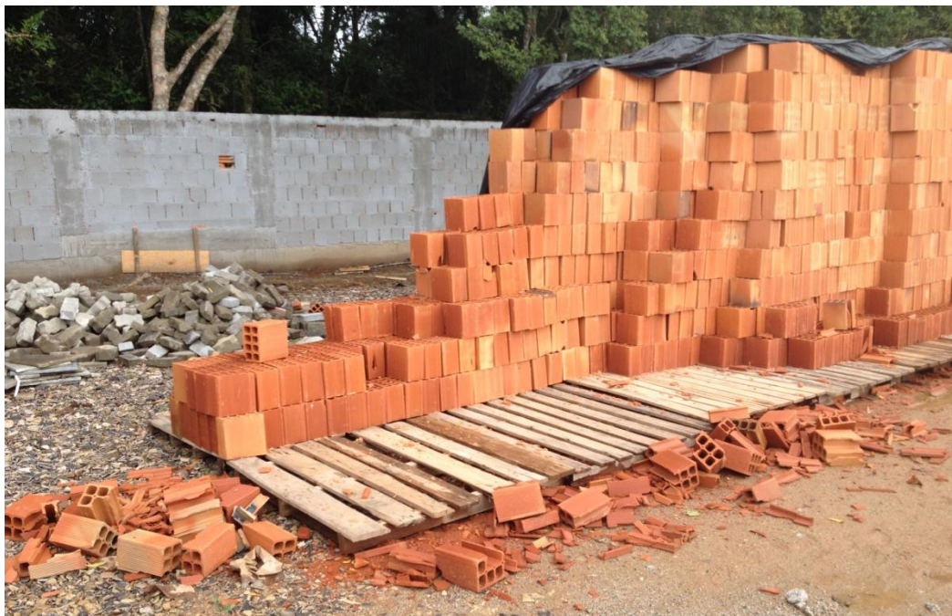
Figura 33 - Materiais soltos e sem identificação no canteiro antes do 5S. Fonte: Acervo da autora.
