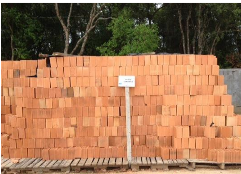
Figura 38 - Identificação dos materiais com placa em acrílico. Fonte: Acervo da autora.
