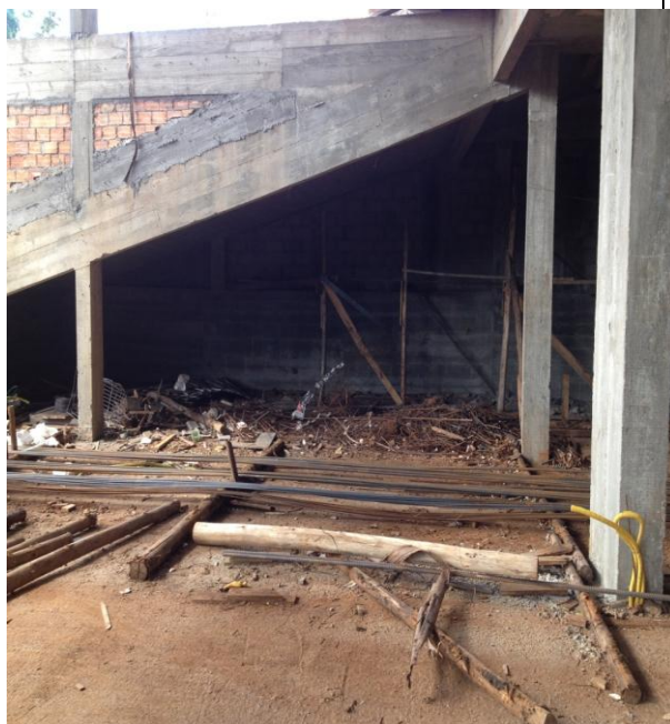
Figura 5 - Central de armadura da empresa X. Fonte: Acervo da autora.
