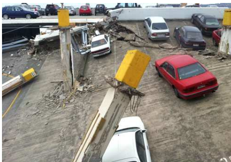
Figura 6 - Ruptura por punção em prédio garagem em Christchurch CBD, Nova Zelândia ( http://reidmiddleton.wordpress.com/2011/03/14/5/ > Acesso em: 03 maio 2013)
