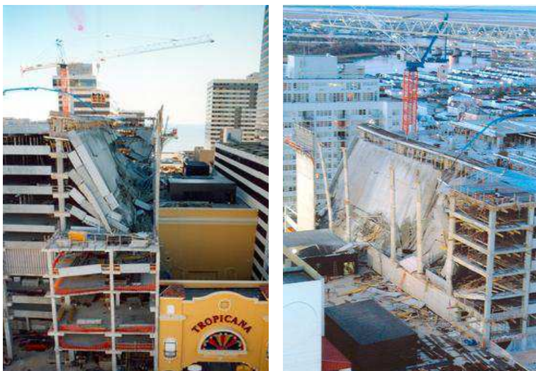
Figura 5 - Colapso da estrutura do Cassino Tropicana, NJ, EUA. (ENGEL, R. H. et al , 2003)
