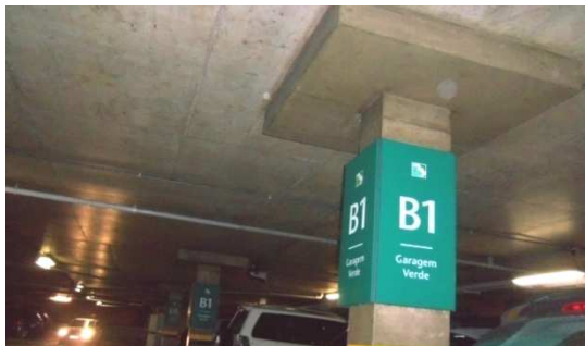
Figura 2 - Lajes lisas com capitéis no Shopping Beira Mar
