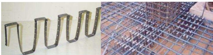
Figura 24 - Armadura tipo shearband ou em fita (PILAKOUTAS e LI, 1997, apud RABELLO, F. T., 2010)
