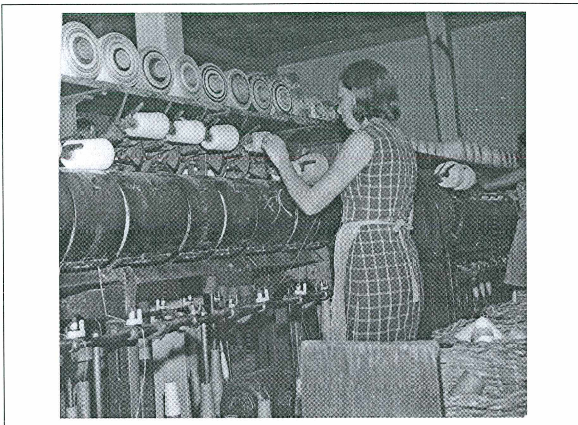
Operárias trabalhando na maçarqueira, que tinha a função de paralelização e estiramento dos fios.
