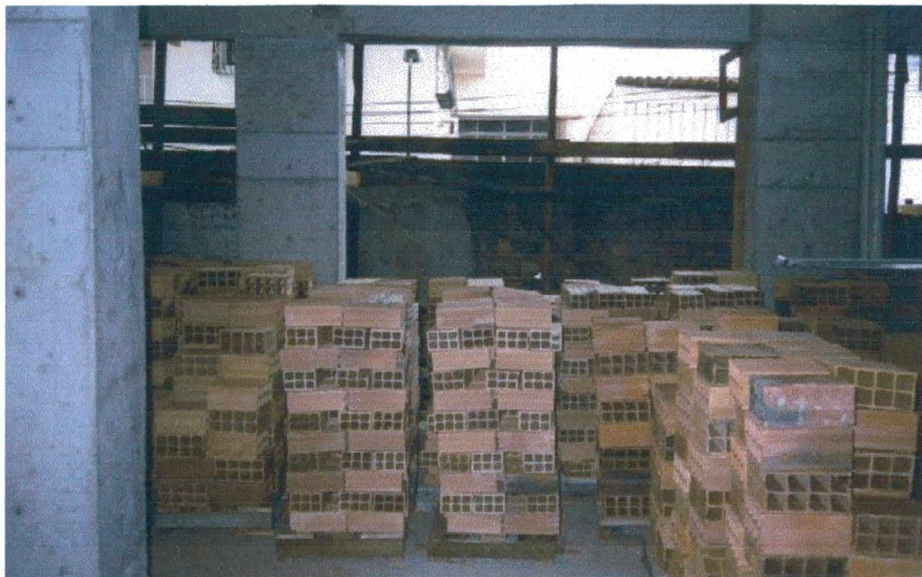
Figura 5- Paletização dos tijolos em obra.
