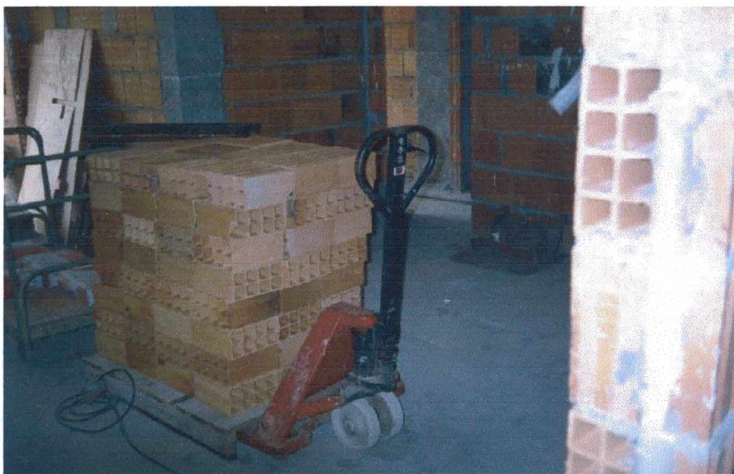
Figura 6- Transporte dos tijolos com os transpaletes.
