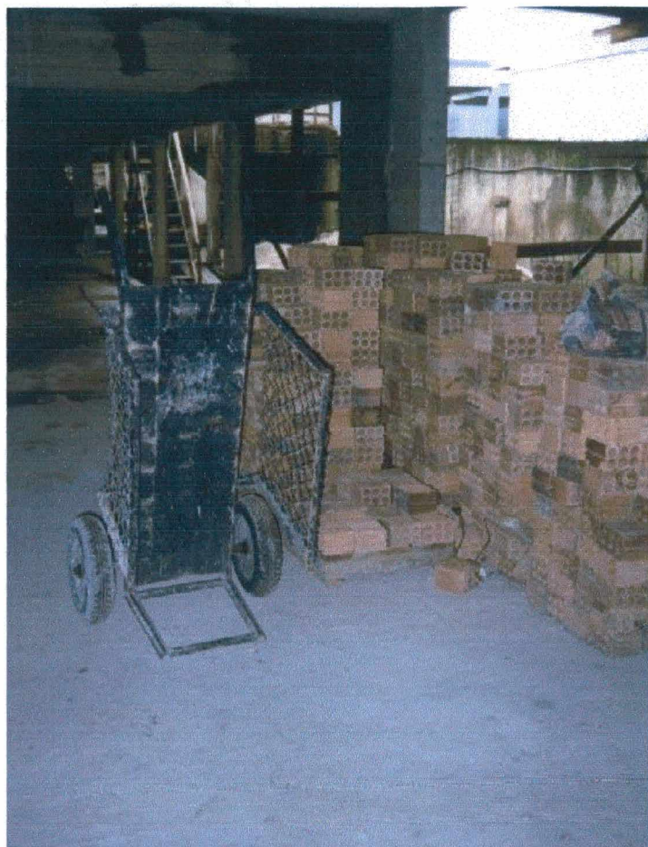
Figura 7- Transporte dos tijolos com os transpaletes.
