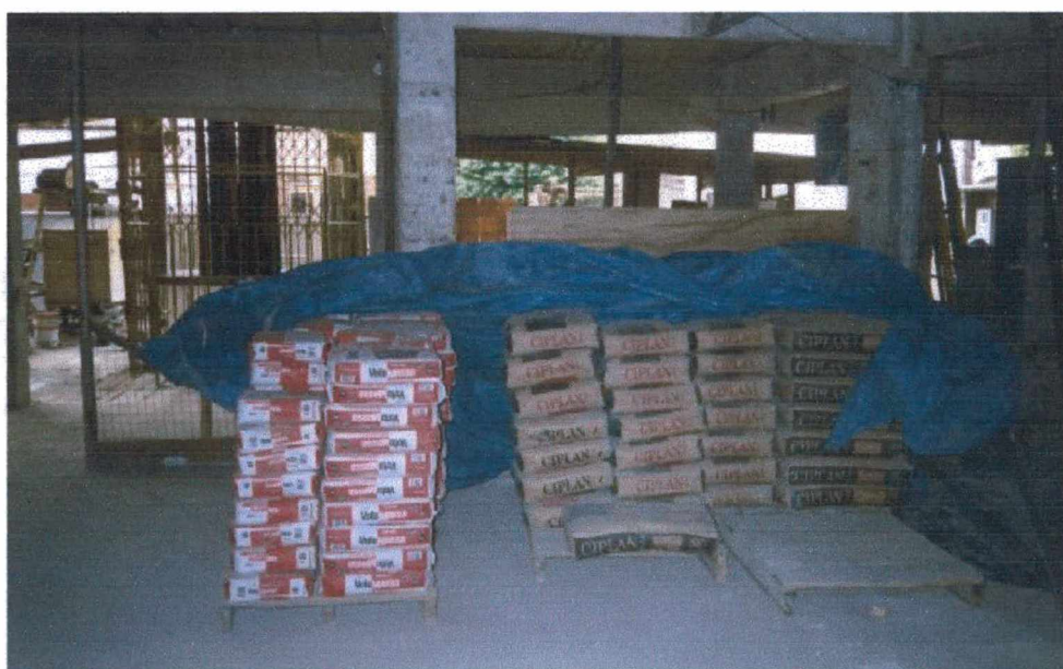
Figura 4- Paletização dos sacos de cimento em obra.
