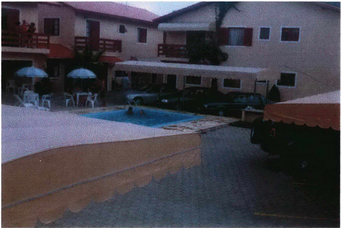
Vista do Estacionamento e Piscina do Residencial Nayara
