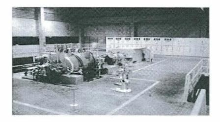
\* Figura demonstrativa de uma central termoelétrica com características similares às da central proposta para a empresa Alpha, demonstrando a disposição do equipamento principal de geração (turbina a gás), painéis de controle (ao fundo) e uma construção civil (galpão) para proteção e operacionalização da central.
