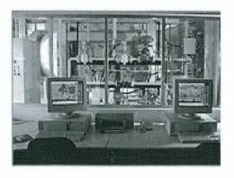
\*Central termoelétrica em co-geração composta por dois turbogeradores a gás natural produzindo 10.400 kW em energia elétrica, além de vapor para o processo.
