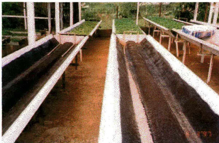
Figura 6.2 – Bancada de crescimento em construção.
