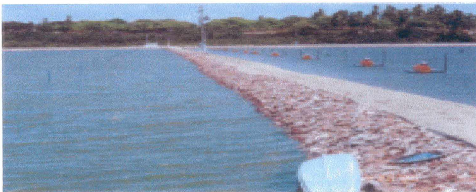
FIGURA X – Vista da Parte Superior de um Talude (2000) FONTE: GUIA PURINA
