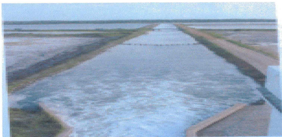
FIGURA IX – Vista Aérea de um Canal de Adução de Água (2000)
