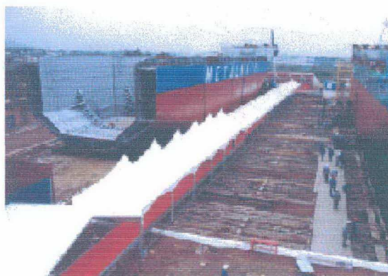
Figura 14: Vista aérea da passarela
