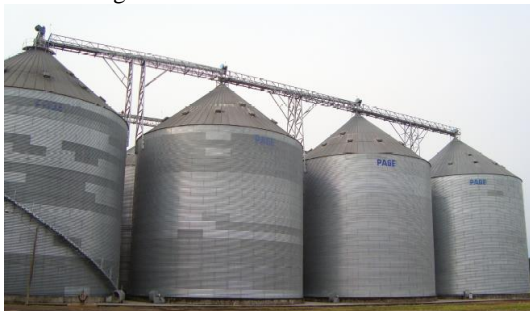
Figura 9 - Armazenagem em silos metálicos.
