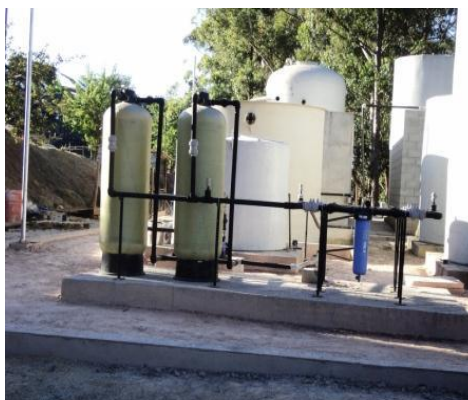
Figura 39: Sistema proposto – tratamento complementar
