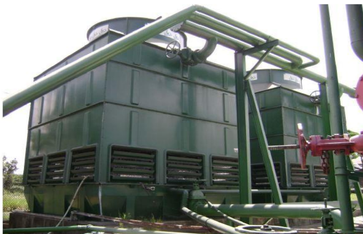
Figura 38: Ponto para reúso – torres de resfriamento
