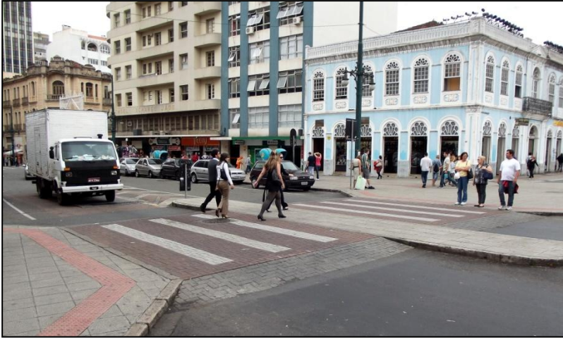
Figura 10 – Travessia elevada para pedestres - Curitiba/PR.
