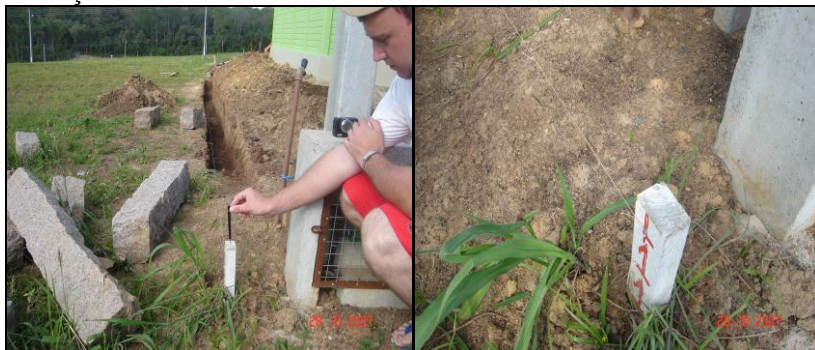
Figura 31: detalhe da construção de um muro com parte sendo edificada sobre o imóvel vizinho; o ponto limite de propriedade nesse caso é o centro da estaca.
