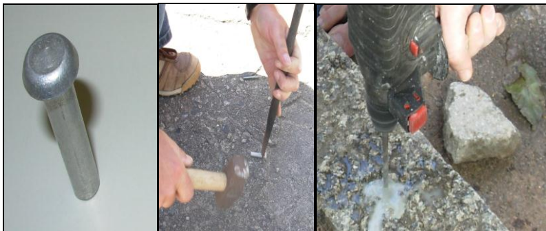
Figura 39: ponto de referência sendo preparado para ser demarcado.
