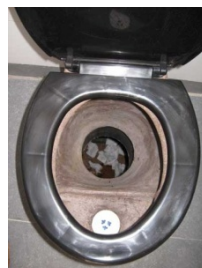
Figura 04. Vaso sanitário segregador de banheiro seco - Gana.
