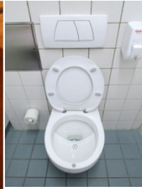
Figura 07. Vaso sanitário segregador a vácuo (1L/ fezes, 0,5L/ urina) - Roediger®, Suécia.
