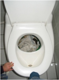
Figura 05. Vaso sanitário segregador de banheiro seco – prédio GIZ, Eschborn, Alemanha.
