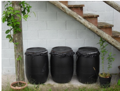
Figura 23. Tanques de armazenamento de urina.
