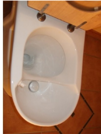
Figura 06. Vaso sanitário segregador a vácuo (1L/fezes, 0,5L/urina) - prédio GIZ, Eschborn, Alemanha.
