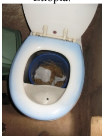
Figura 02. Vaso sanitário segregador de banheiro seco - Addis Ababa, Etiópia.
