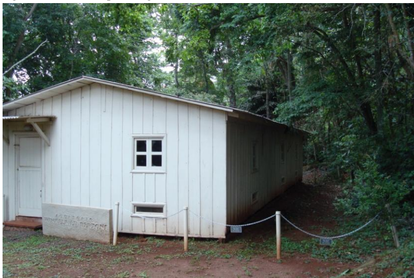
Figura 16 – Imóvel que abrigou a biblioteca de Bertoni.
