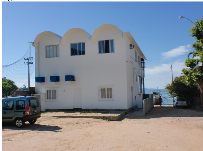
Figura 7 - Prédio da COLIMAR.
