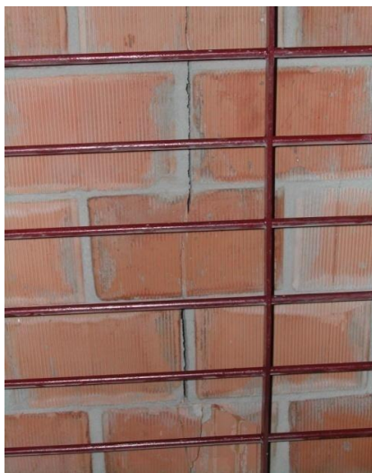
Figura 35 - Surgimento de trincas da PCE29.
