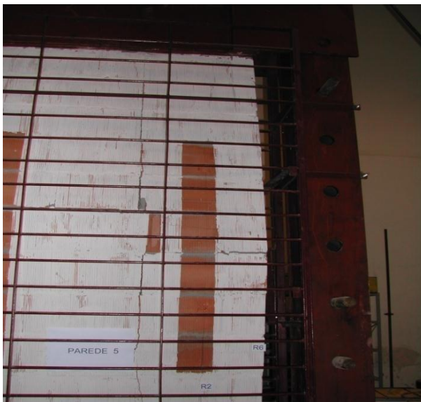
Figura 33 - Rompimento e surgimento de fissura vertical da PSE44.
