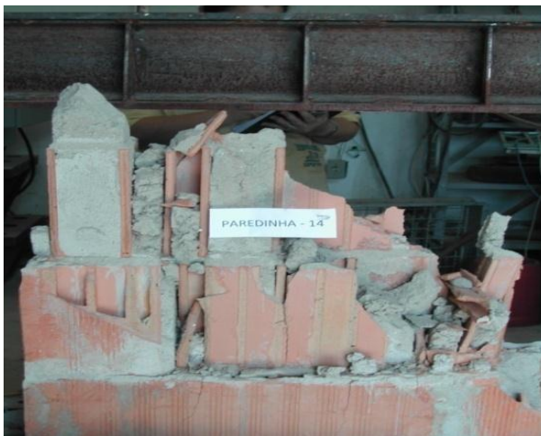
Figura 18 - Rompimento da PadCE44.
