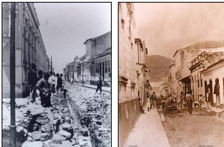
Imagens 21 e 22 - Rua Trajano, antiga Rua Livramento, durante assentamento da primeira rede de águas e esgoto (1908) e Rua João Pinto (1910). Imagens: Casa da Memória de Florianópolis
