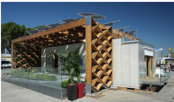
Figura 34 – Foto do exterior da Para Eco-House
