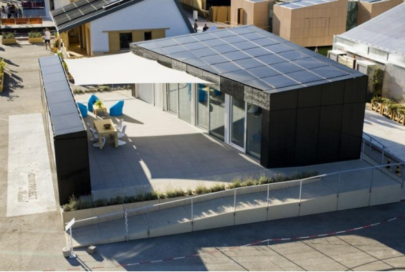
Figura 21 – Foto do pátio da Odoos com a casa à direita e a parede externa à esquerda
