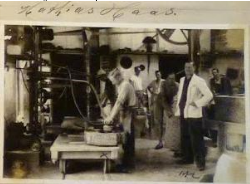
Figura 43 - Instalações da marmoraria na década de 1930
