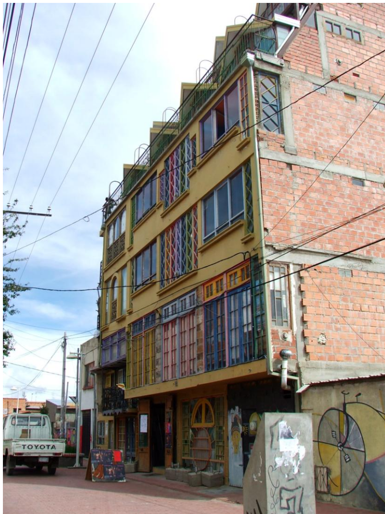
Figura 12. Sede Compa Fonte: Autor (03/2011)
