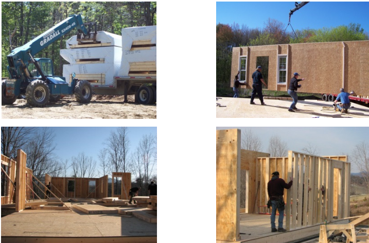
Figura 5 – Etapas de montagem de uma edificação no sistema panelizado.
