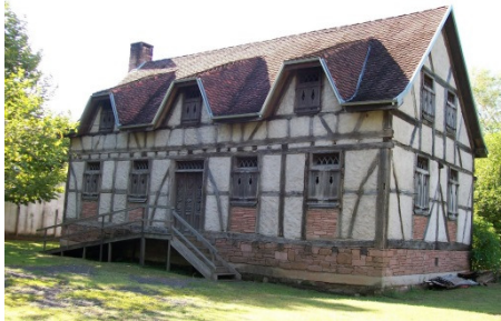
Figura 3 – Construção em enxaimel.
