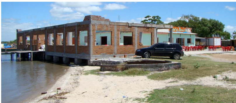
Figura 13: Obras de ampliação do Restaurante Pontal da Barra dentro do canal São Gonçalo
